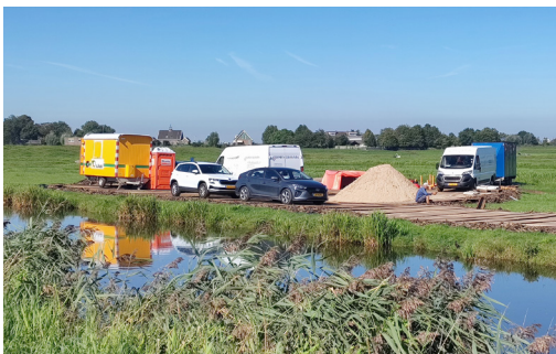
De reparatie van het kabellek
